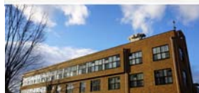
旧 仙台高等工業学校建築学科棟
